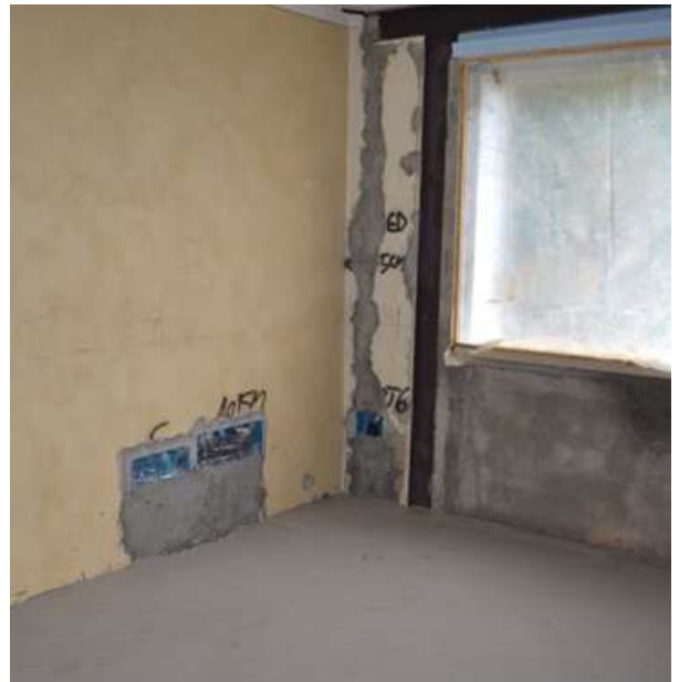
Pavimento pronto per la posa; Floor ready for laying
