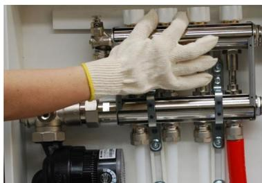
9. Riempimento impianto: apertura del primo detentore ruotando la chiave a brugola in senso antiorario
