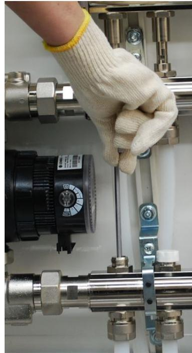
10. Riempimento impianto: chiusura dei successivi detentori ruotando la chiave a brugola in senso orario
