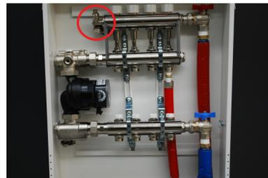
7. Riempimento impianto: chiudere le valvole di andata/ritorno del circuito primario (rossa e blu); apertura manuale del primo otturatore termostatico e ruotando in senso antiorario l'apposita manopola
